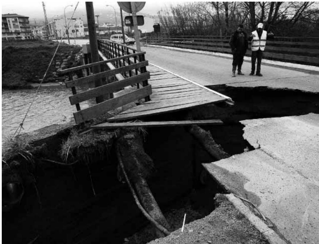
El agua descalzó uno de los pilares del puente, que cedió y provocó un boquete de grandes dimensiones
