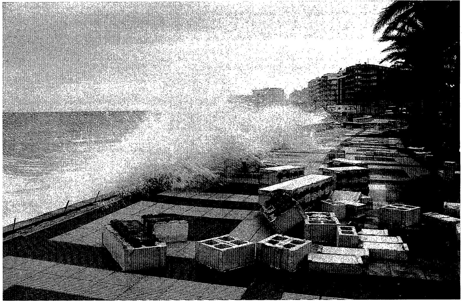
El temporal arrastró la arena sobre la que se construyó el paseo S'Abanell de Blanes y provocó el hundimiento de parte del mismo
