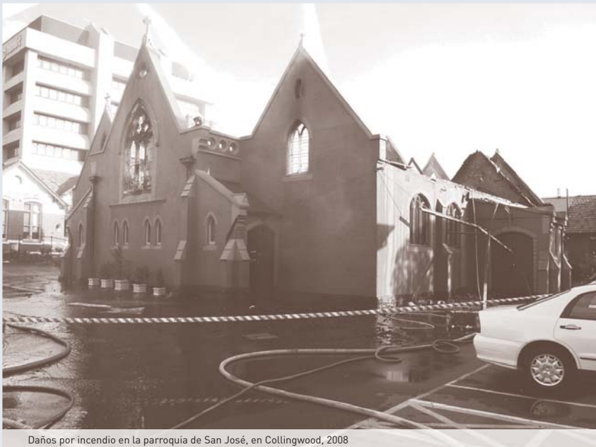
Daños por incendio en la parroquia de San José, en Collingwood, 2008
