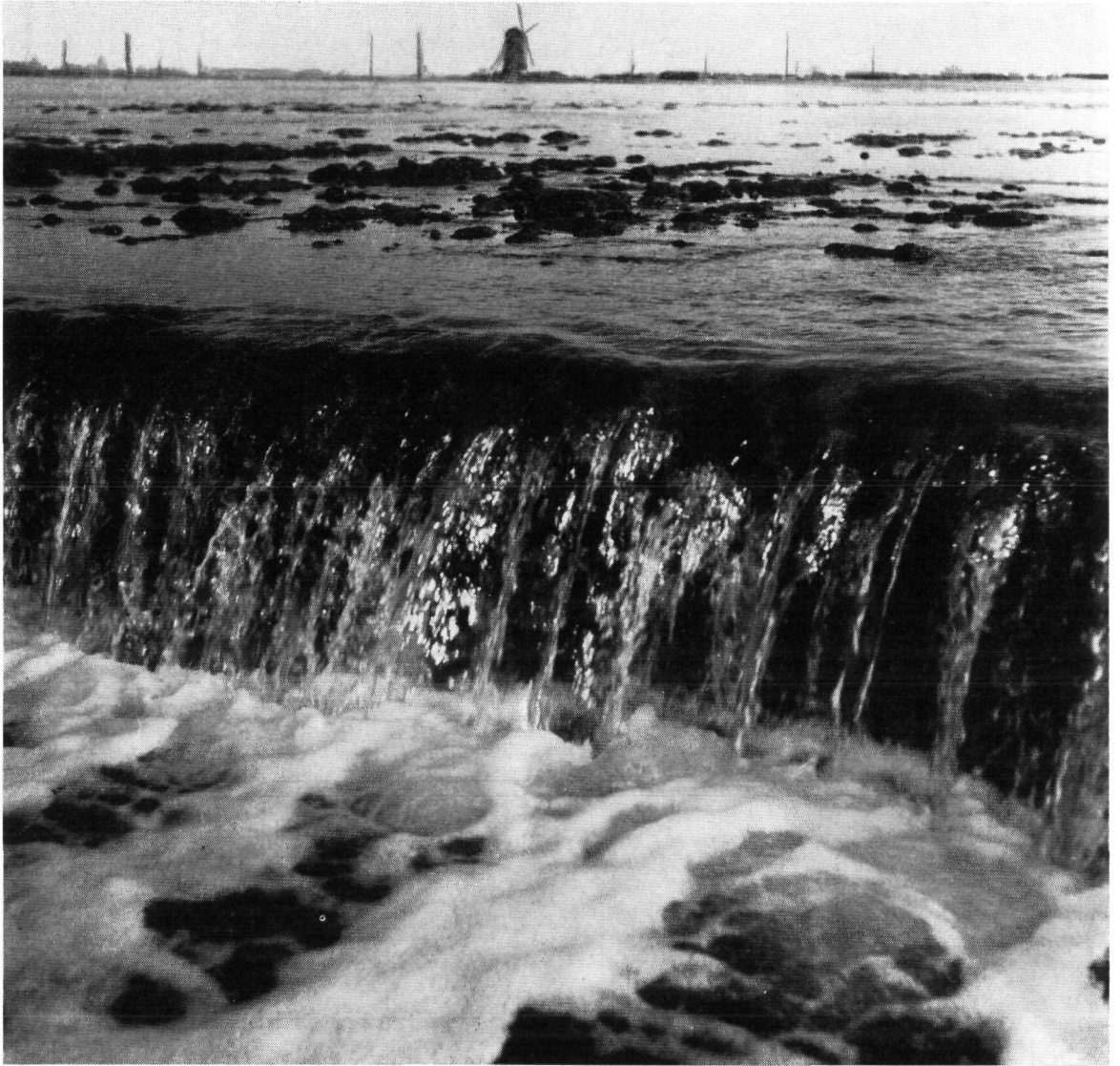
Fig. 4.117. Bij eb vormt het uitstromende water aan het einde van de geulen in de polder kleine watervallen, waardoor het geulensysteem zich steeds verder landwaarts uitbreidt. Op de achtergrond de nog niet ingestorte molen van Ouwerkerk. Foto Particam Pictures, d.d. 23 april 1953
