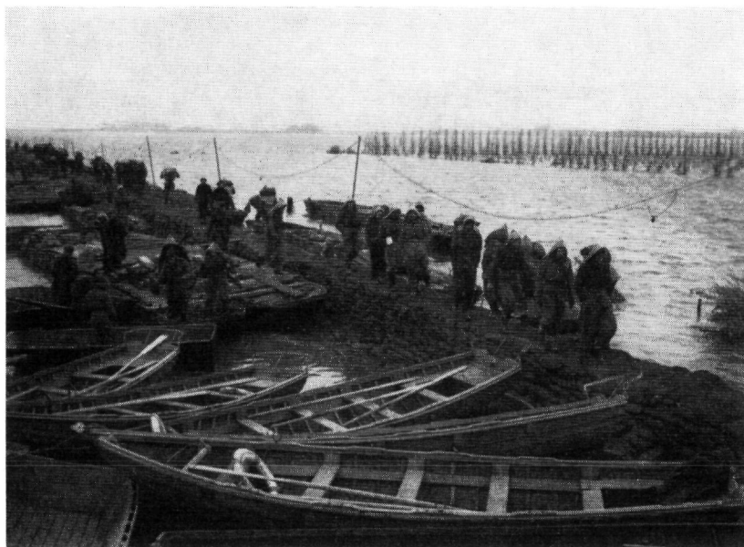
Fig. 4.146. Werkzaamheden aan de Vierde Weg in de Reigersbergse Polder. Vervoer van zandzakken met pontons en aanvalsboten in de sloten langs de weg bij laagwater. A.N.P.-foto
