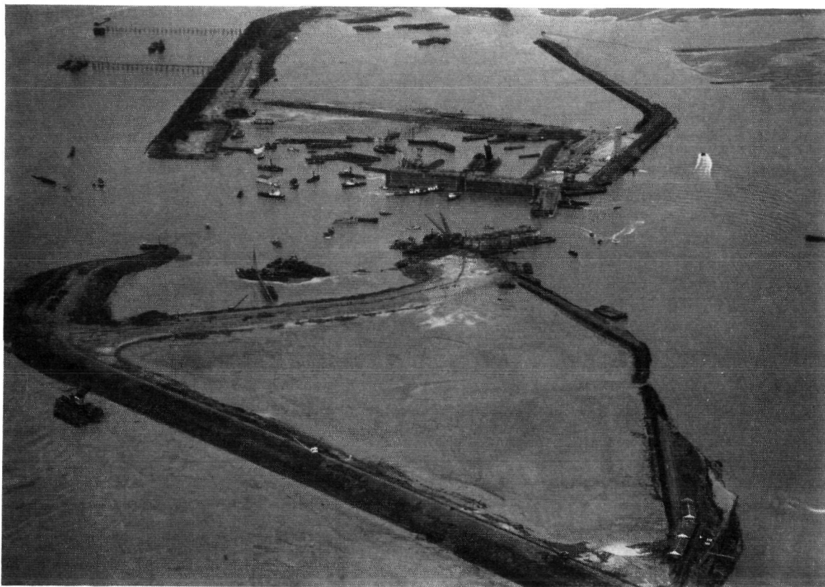
Fig. 4.123. Overzicht van het oostelijke sluitgat ten zuiden van Ouwerkerk op 6 november 1953. De sluitcaisson is reeds gemeerd achter het westelijke landhoofd. Links op de foto het Brokkengat. Foto K.L.M. - Aerocarto
