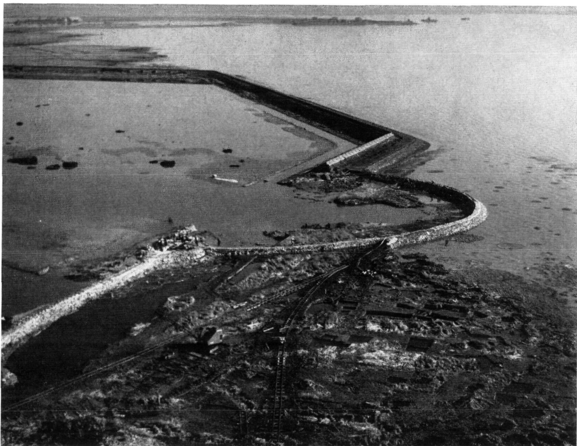
Fig. 4.144. Het gedichte stroomgat in de hoofdwaterkering van de Reigersbergse Polder ten oosten van de Derde Weg door middel van een ringkade over het schor
