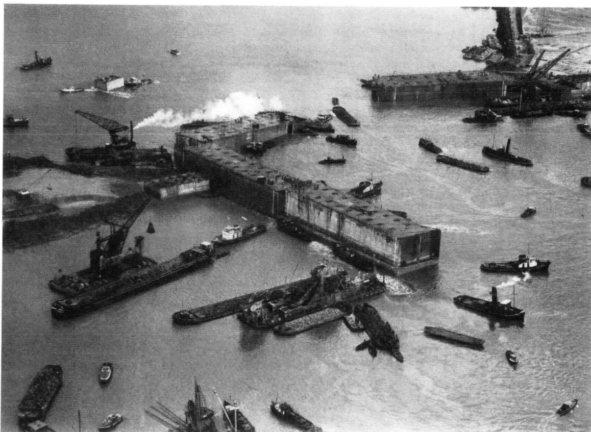
Fig. 4.124. Oostelijk sluitgat ten zuiden van Ouwerkerk op 6 november 1953 gezien vanuit het zuidwesten. De sluitcaisson ligt gemeerd tegen het westelijke landhoofd. De laatste voorbereidingsen worden getroffen voor de nachtelijke blokkering. Foto K.L.M. - Aerocarto
