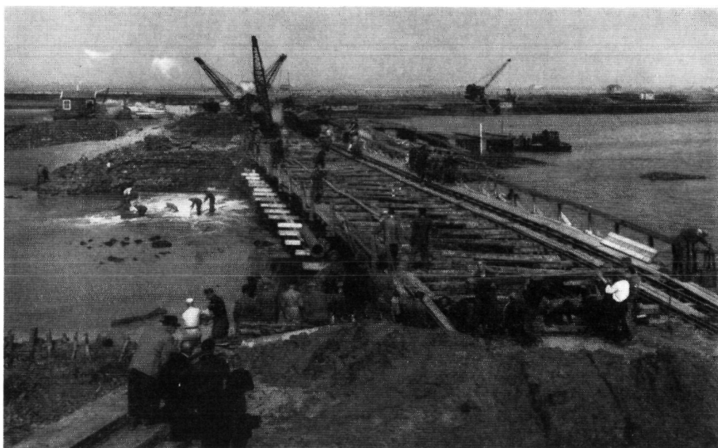
Fig. 4.132. Het gereedmaken van de steiger voor de eerste sluiting; op de achtergrond de hevelinstallatie aan de westzijde van het sluitgat, dd. 25 augustus 1954 Foto De Feyter
