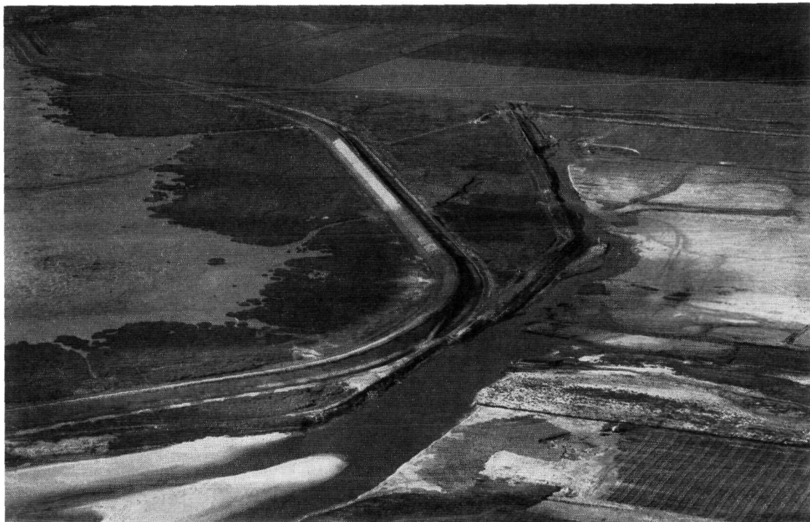
Fig. 4.151. De nieuwe hoofdwaterkering over het schor voor de Reigersbergse Polder, d.d. 24 oktober 1953
