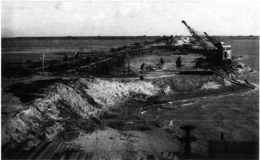
Fig. 4.134. Het maken van de sluitkade aan de polderzijde van de stenen dam d.d. 4 oktober 1954 Foto De Feyter
