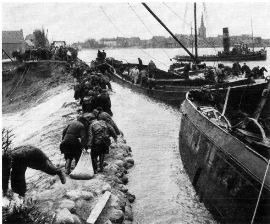
Fig. 4.41. Dichting stroomgat te Ouderkerk aan de IJssel door twee schepen en zandzakkendam op 1 februari 1953 Foto Particam Pictures
