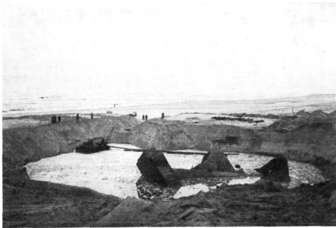
Fig. 4.35. Opruiming bunker door middel van een zandzuiger onder Wassenaar
