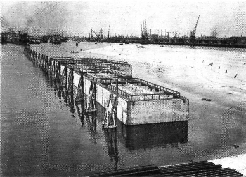
Fig. 4.14. Opslag van caissons in de Waalhaven te Rotterdam Foto Tom Kroeze
