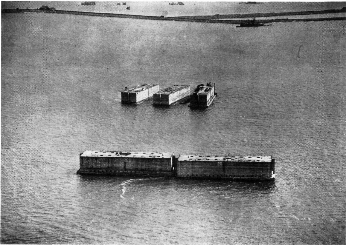
Fig. 4.21. Ligplaats van Phoenixcaissons type AX op de Nunneplaat in de Oosterschelde. Op de achtergrond de zuidelijke zeedijk van het waterschap Schouwen Foto K.L.M.-Aerocarto
