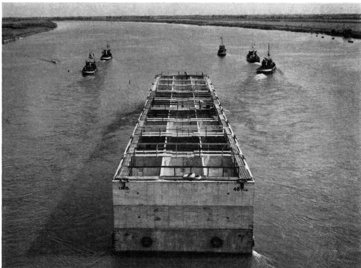
Fig. 4.16. Het transport van een 10 m hoge, samengestelde eenheidscaisson in de Oude Maas op weg naar het rampgebied Foto Tom Kroeze
