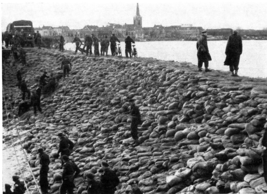
Fig. 4.42. De zandzakkendam in het stroomgat te Ouderkerk aan de IJssel op 3 februari 1953 Foto G. Mul
