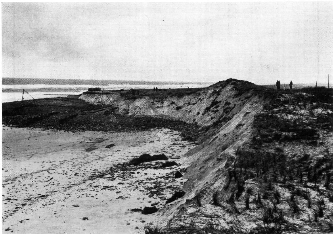
Fig. 4.27. Duinafslag bij de aansluiting op de Hondsbosse Zeewering te Kamperduin
