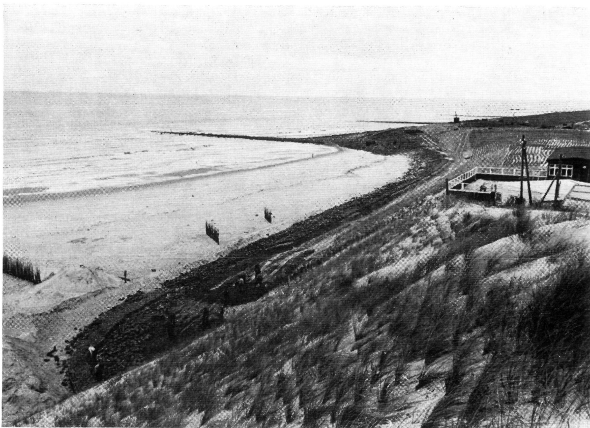
Fig. 4.30. Het herstel van de steenglooiing van de Hondsbosse Zeewering en het maken van de duinvoetverdediging tussen strandhoofd 29 en 30 te Kamperduin Foto De Jong
