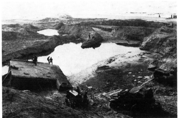
Fig. 4.36. Met behulp van een zandzuiger in het strand verzonken bunker nabij Katwijk
