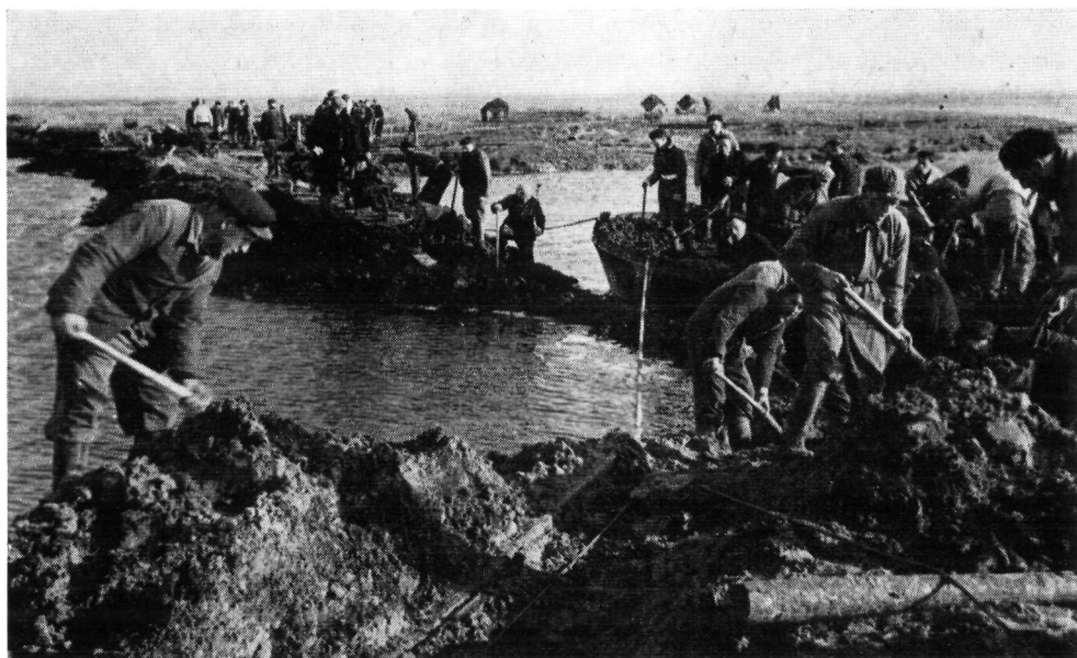
Fig. 4.26. Het dichten van de doorbraak in de hoofdwaterkering van de Polder de Eendragt op 25 februari 1953 Foto De Waal
