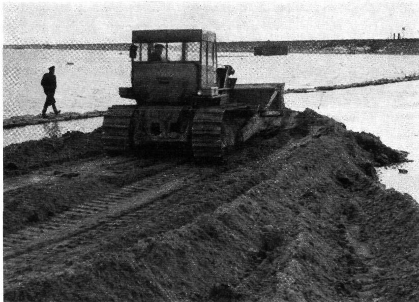
Fig. 4.61. Het dichten van de doorbraak in de oostelijke dijk van de Rijkstramweghaven te Numansdorp. Door een bulldozer wordt het zand tussen de aangelegde kleikade en de zandzakkendam geduwd.
