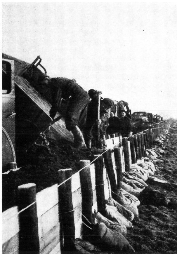
Fig. 4.56. Het aanbrengen met behulp van kipauto's van de kleivulling in de kistdam op de westelijke kade van het Kanaal door Voorne
