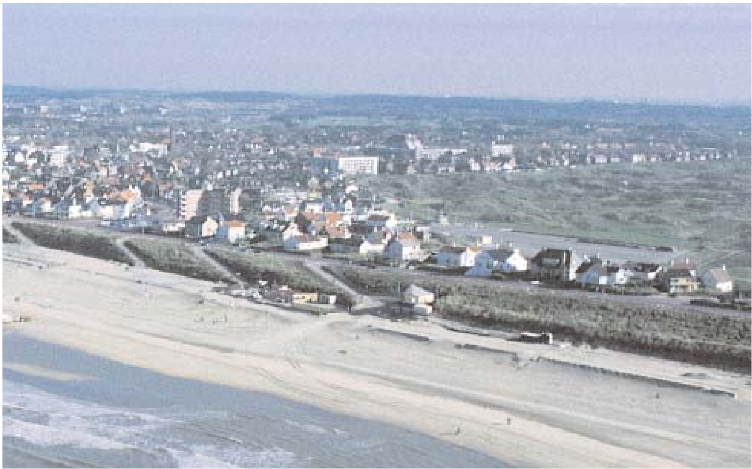
Kust bij Zandvoort. Bebouwing vergroot de druk vanuit land op de kust.
