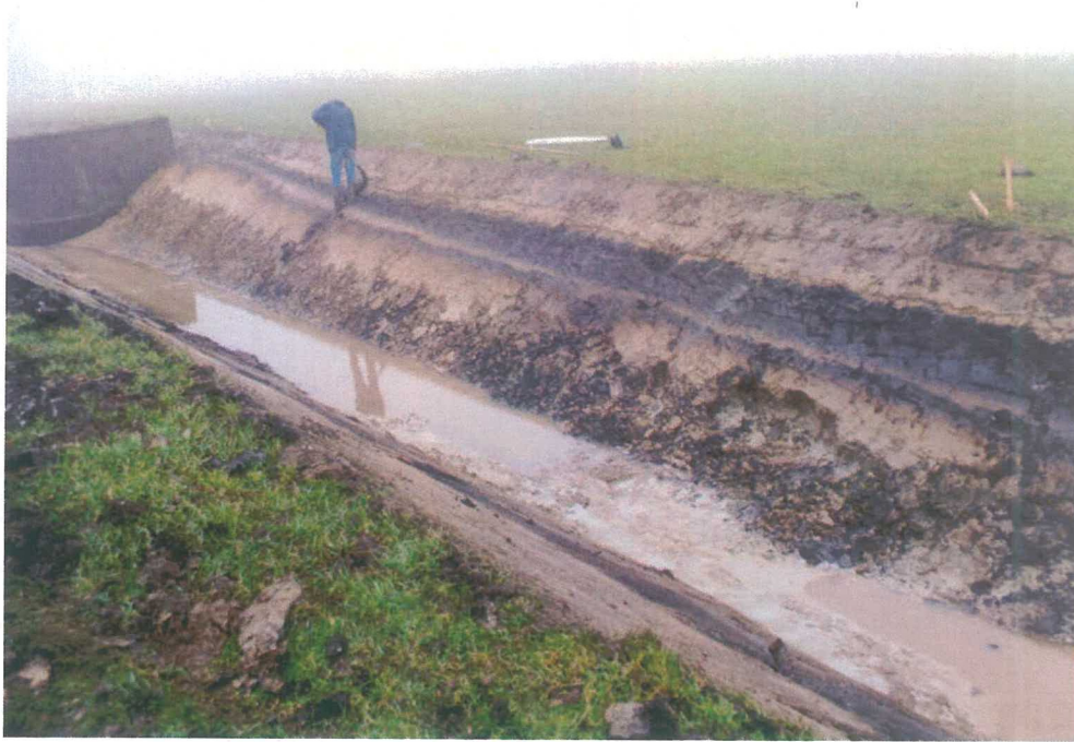
Foto 7: De westzijde van de dekzandopduiking tussen 737 m (K2) en 804 m (K1; bijlage 1 en 4). Op de foto is te zien is dat de veenlaag tegen de zandkop uitwigt. De plaats waar gegraven wordt is monsterlocatie K2.
