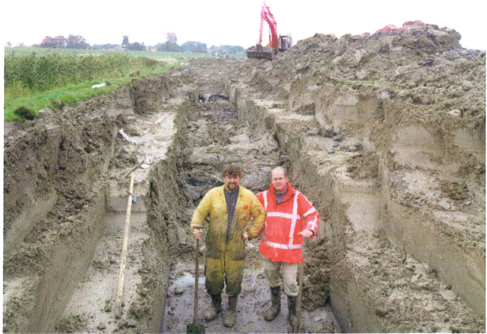
Foto 1: Pijpijnsleuf 1 (op ca. 200 m ref. punt 1), met op de achtergrond het terpdorpje Vierhuizen. De sleuf verspringt op dit punt van twee trappen naar drie trappen; dit om het inklappen van de profielwand te voorkomen.
