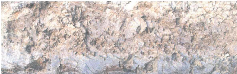
Foto 2 : Detail uit de profielwand. Fraai gestapelde plaggen ophoging bestaande uit een afwisseling van Tinga klei en Tinga veen.
