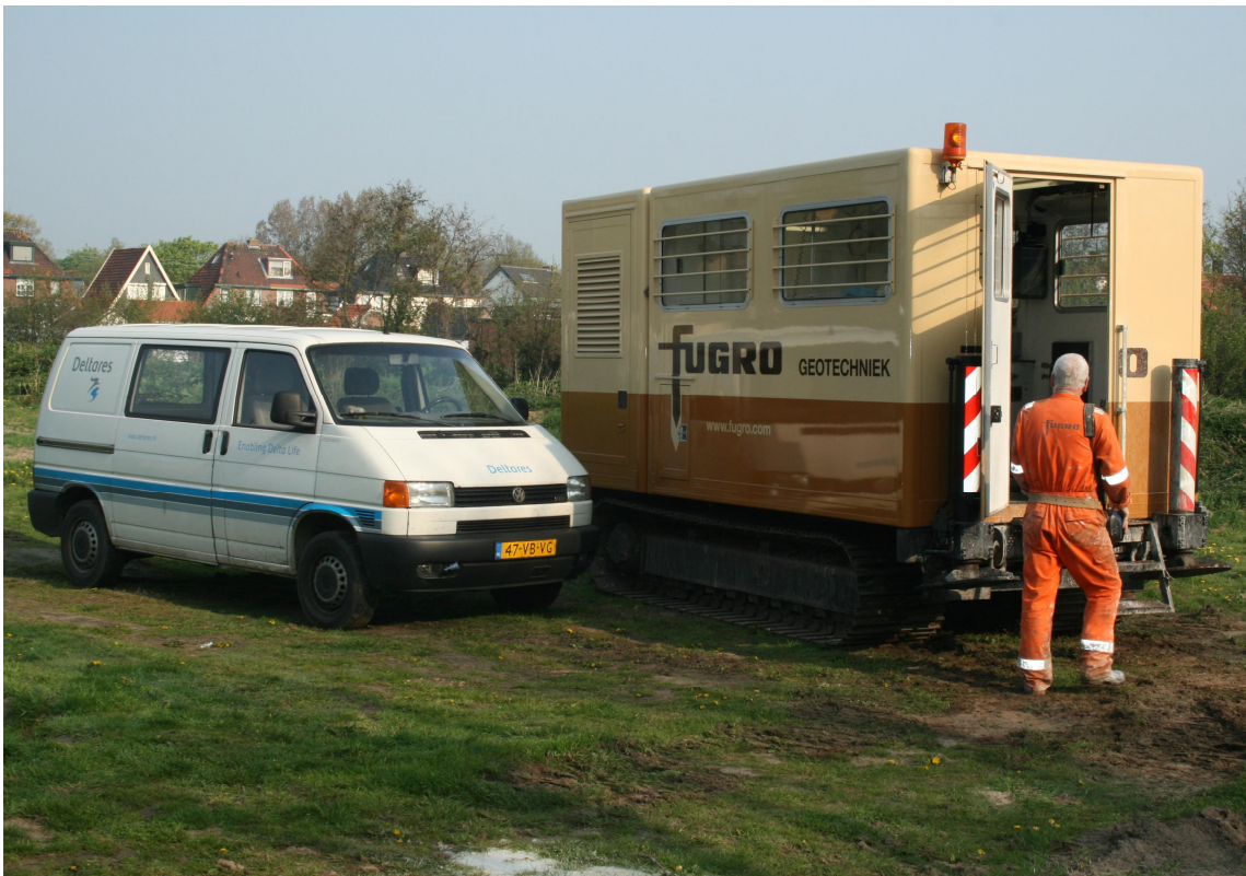
Afb. 9. De Begemann boorwagen aan het werk in het uitwerkplekgebied UWP 2.
