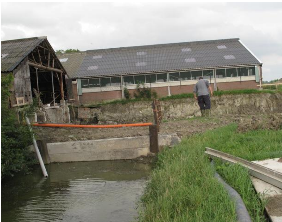
Afb. 8: Egge Knol inspecteert een profielwand die gegraven is voor de aanleg van een nieuwe schuur bij De Grote Knol (er bestaat een familieverband). In de wand is de ophogingslaag van de state ontsloten en daar heeft Egge in de grijze ophogingsklei een 13 e eeuwse scherf gevonden. De zwarte / venige laag is niet ontsloten in de profielwand. Het organische niveau ligt daar op een diepte van circa 2.0 m onder het maaiveld (zie Afb. 5). De kwelderklei (deklaag) tussen de zwarte band en de ophogings laag is op deze plaats circa 1.0 m dik.
