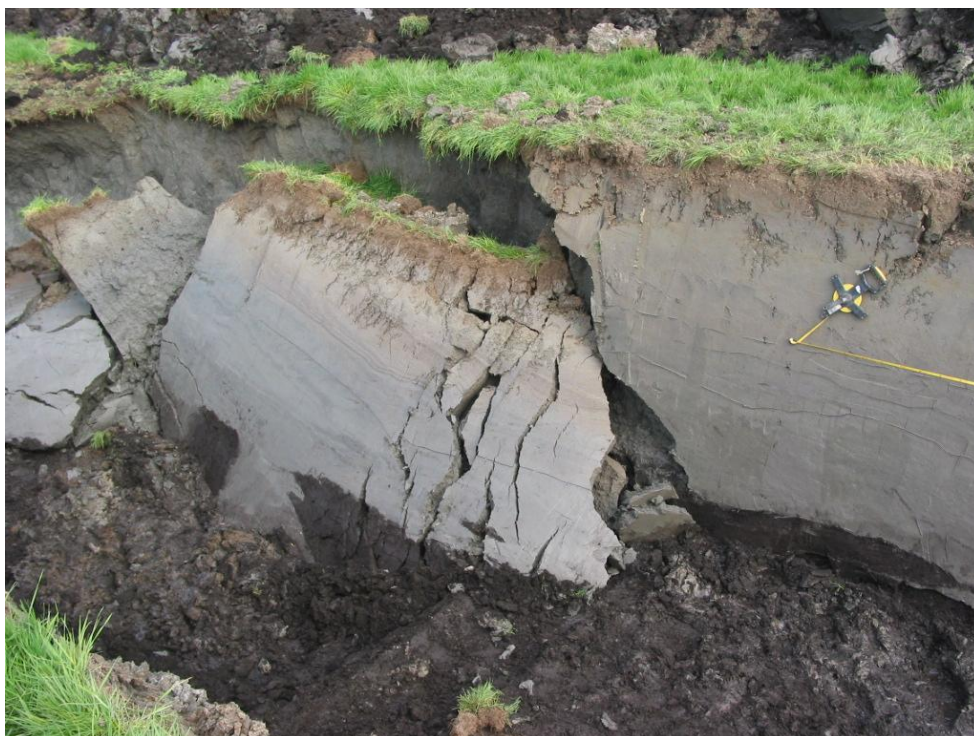
Foto 24: Rechterzijde van het ingestorte profiel op 37-41 m. De veenbrokstructuur ingebed in de Ges-klei (zie Foto 22) is nog goed herkenbaar.
