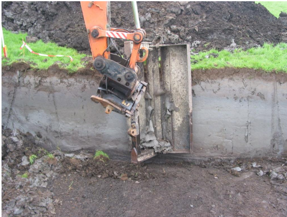
Foto 5: De profielschaaf van de firma Bergman. Door gebruik te maken van de profielschaaf hoefde het profiel slechts licht opgeschaafd (bijgewerkt) worden, zie onderstaande Foto 6.
