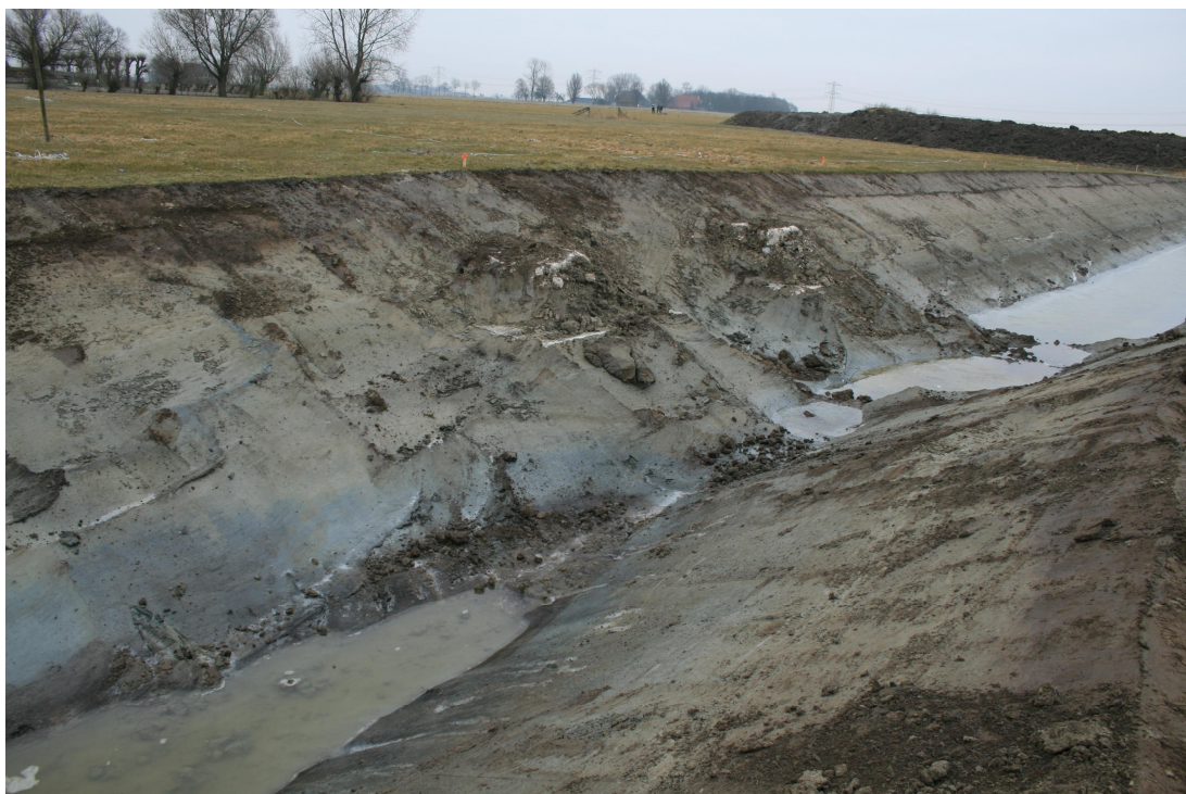
Foto 20: Overgang van het gebied met Hollandveen in de ondergrond naar de stroomgordel van de getijdengeul (achtergrond). De wegduikende veenlaag is nog net te zien boven het slootwater op de voorgrond van de foto. De nieuwe sloot heeft een zeer scheve aansnijding en de loop van de geul. De scheve aansnijding tussen sloot en stroomgordel van de geul ligt tussen de boringen 1491 – 1514 (Afb. 1).
