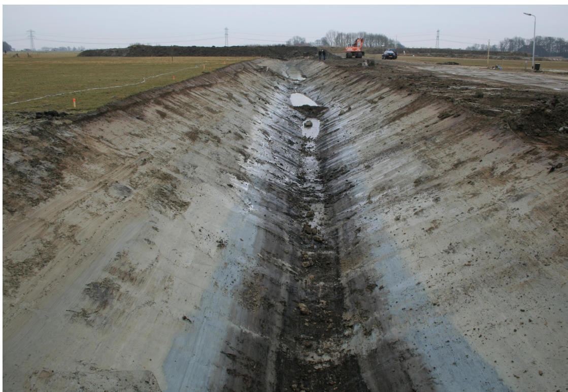
Foto 18: Aanleg van een nieuwe sloot, gezien vanuit het westen richting oosten (16 maart 2010). Boorlocatie1514 (Afb. 1) ligt noordelijk van de sloot, links voor de storthoop op de achtergrond. De sloot is getrokken tot in de gelaagde organische eenheid ('Hollandveen'). Op deze gelaagde eenheid komen de brokkelige blauwgrijze kleien van het bovenste klastische pakket voor met daarop de licht beige grijze kleien met kronkelige zandlaagjes (beiden kwelderkleien).
