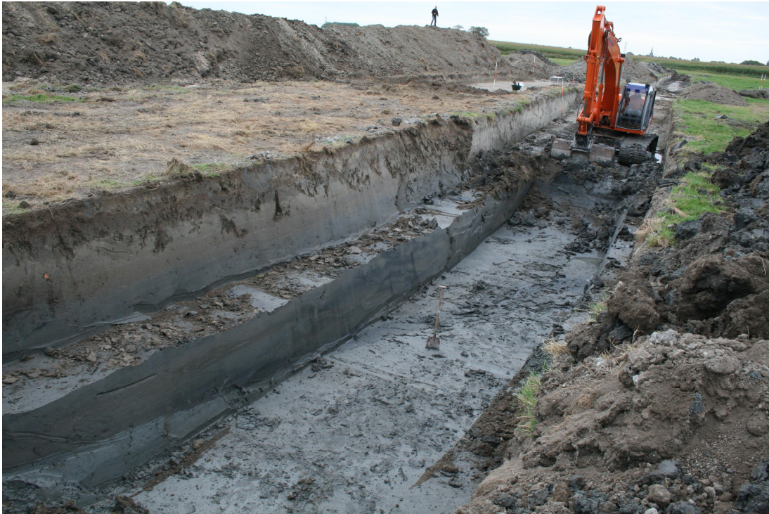
Foto 10: Het trekken van een diepe profielsleuf tijdens de opgraving van het ARC van site 15159 (T15) in de zomer van 2009. Op de voorgrond is de scheve geulinsnijding van de prehistorische geulafzettingen (licht humeuze, bruingrijze klei) te zien in de brokkelige, blauwgrijze klei van het onderste klastische pakket. Foto is genomen aan de zuidzijde van het Oude Diep richting zuid – zuidoosten (op de achtergrond de torenspits van het terpdorp Wirdum).
