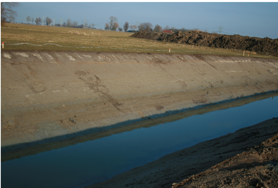
Foto 21: Het gedeelte van de nieuwe sloot (met een oost-west richting) waar in de ondergrond de geulafzettingen voorkomen. Het grootste deel van de in de slootwand ontsloten afzettingen bestaan uit kwelderafzettingen van het bovenste klastische pakket. De stroomgordelrichting van de geul staat onder een zeer schuine hoek met de slootrichting. De meest noordelijk positie van de geulafzettingen (stroomgordel; Afb. 1) reikt niet verder dan halverwege de storthoop op de achtergrond.
